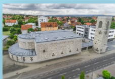
Kath. Pfarrkirche Mariä Unbefleckte Empfängnis in Gunzenhausen (Nürnberger Str. 34) geschlossen wegen der Sanierung
